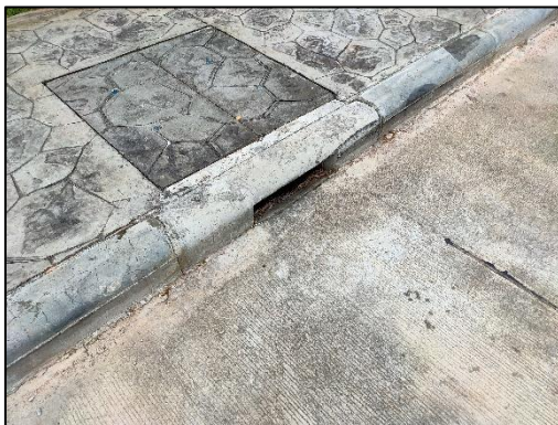
รูปที่ 3-26 ท่อระบายน้ำ และบ่อพักน้ำ
